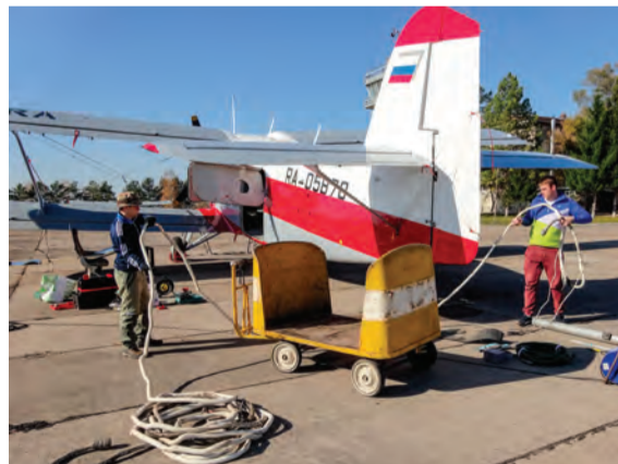
Монтаж петли электроразведки ДИП на самолёт Ан-3
