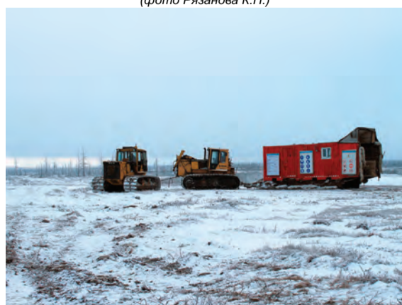
Установка бурового агрегата на точку (фото Кобякова А.С.)
