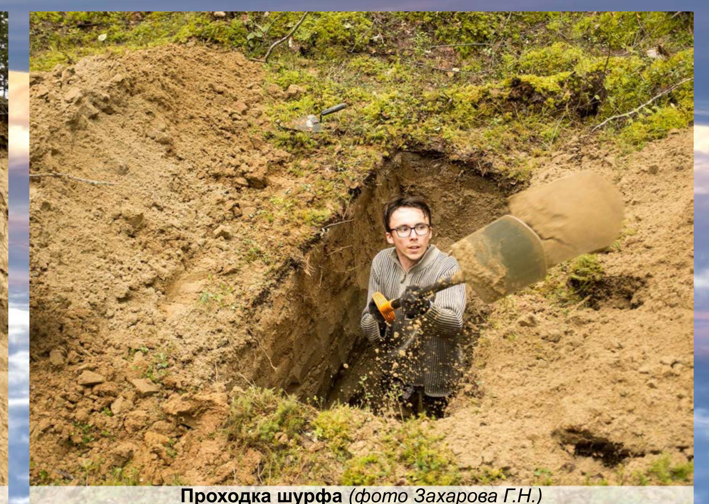
Проходка шурфа (фото Захарова Г.Н.)
