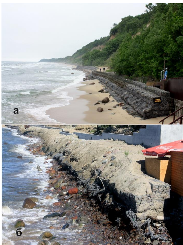
Рисунок 103. Строительство берегозащитных сооружений в г. Светлогорск. Станция наблюдения 17-ССБ-32: а – фото 2013 г., б – фото 2017 г.
