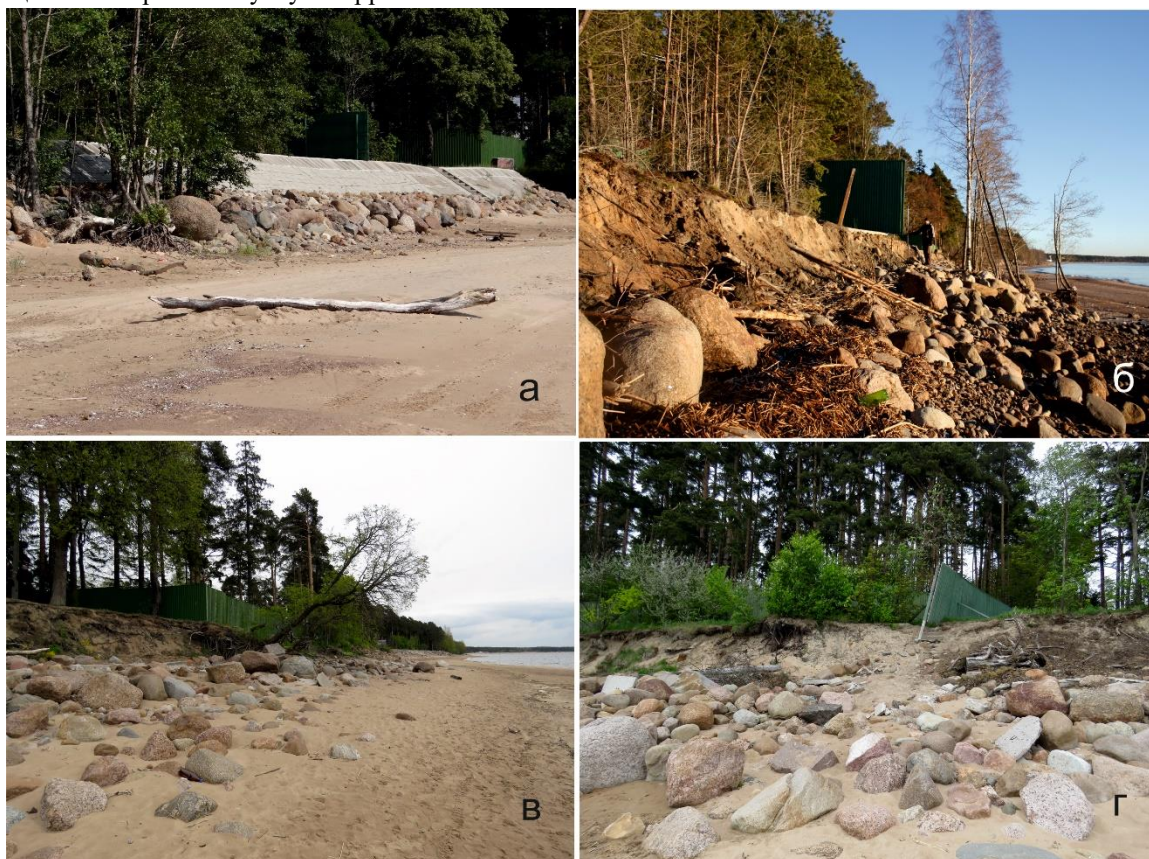
Рисунок 43. Последствия ошибочной берегозащиты 2013 г. в пос. Солнечное: а – 23 июля 2017 г., б – 26.11.2013 г. (после шторма), в, г – 5 июля 2017 г.
