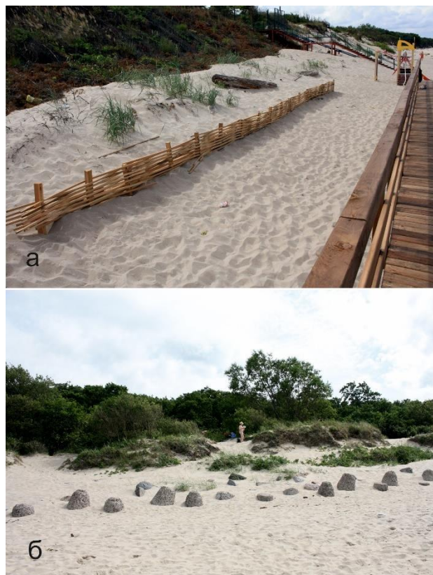
Рис. 141. Техногенное воздействие на дюны: а – меры по укреплению и восстановлению склона дюны в пределах национального парка «Куршская коса» (к югу от точки наблюдения 17-ККБ-4); б – разрушение дюн пешеходами, точка ДФ-17
