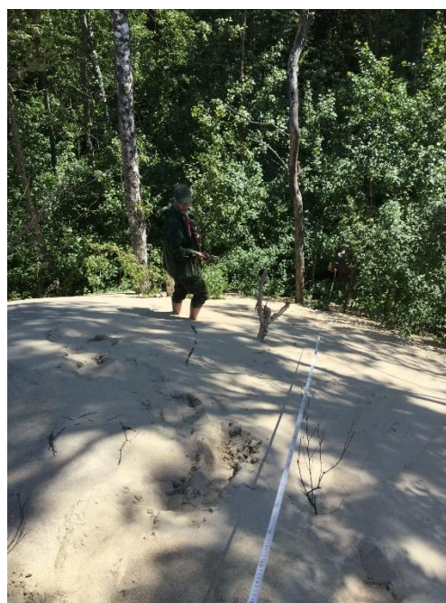
Рисунок 157. Осыпь за котловиной ККК-5
