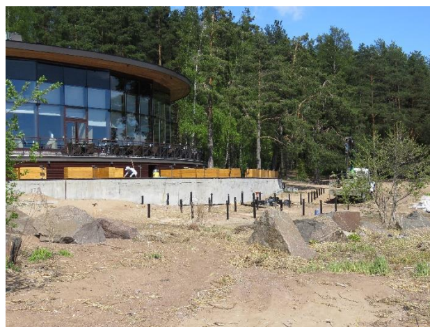
Рисунок 34. Расширение территории ресторана «Ель» в зону непосредственного влияния ЭГП (переработка пляжа волнами)
