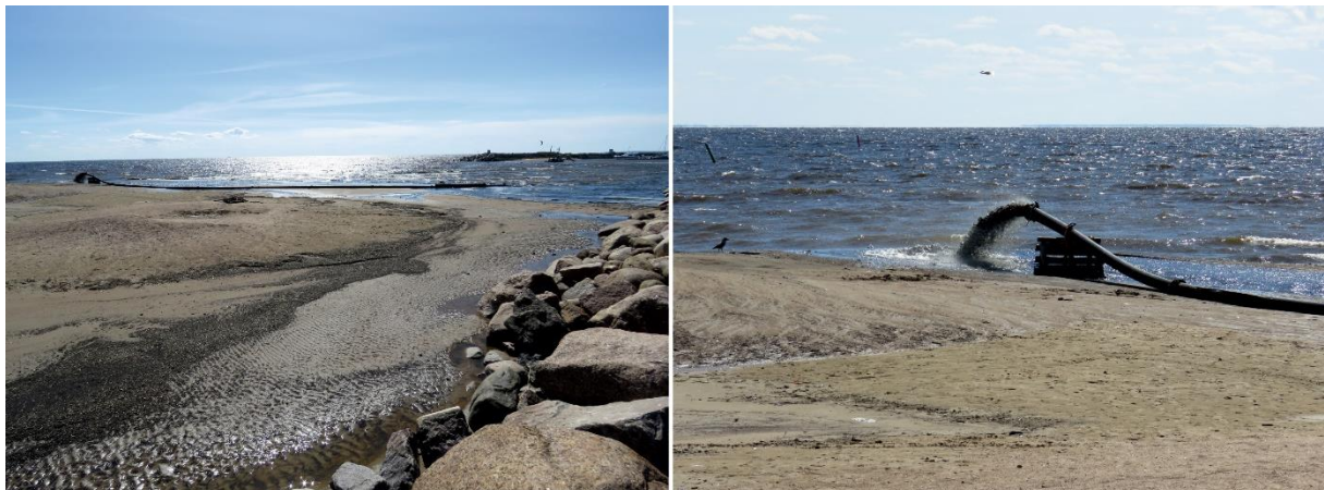
Рисунок 37. Намыв песчаного грунта (рефулирование) к западу от яхт-клуба Терийоки
