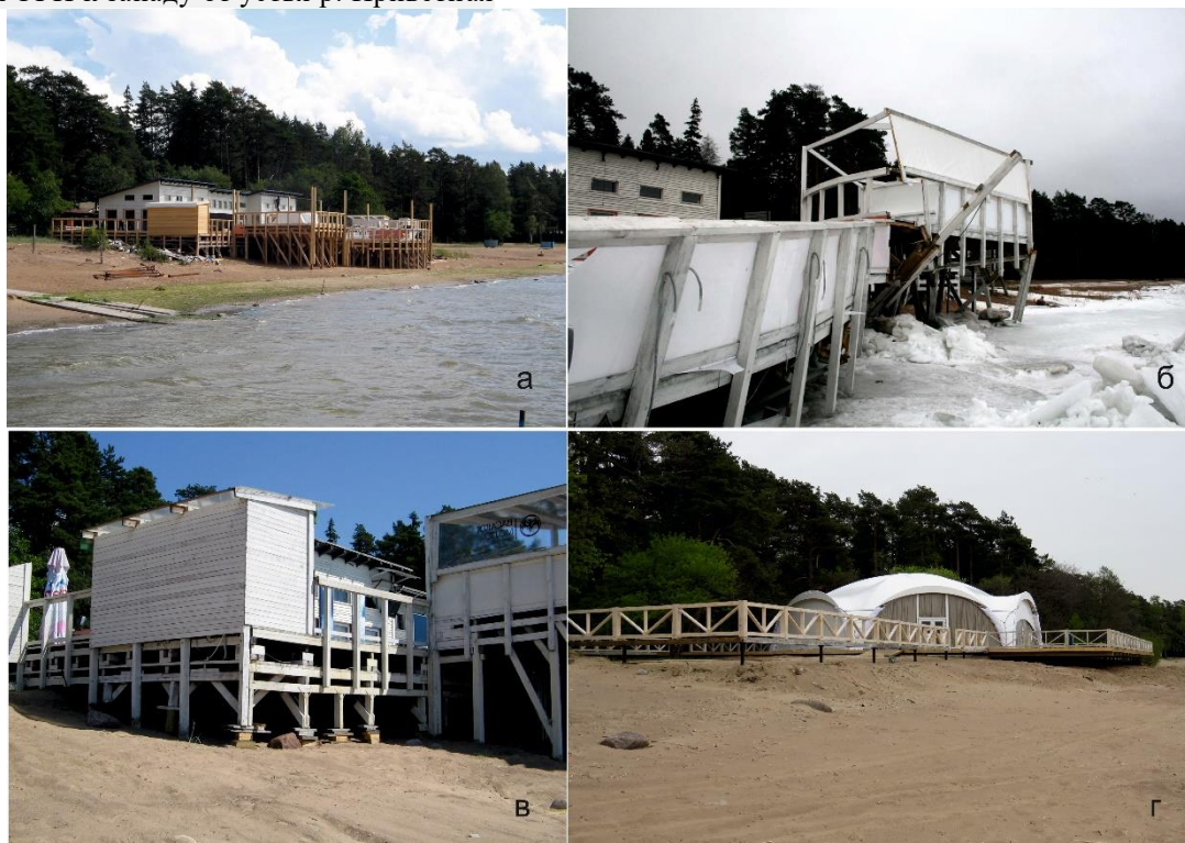
Рисунок 35. Воздействие ЭГП на строение ресторана в береговой зоне Курортного р-она (пос. Комарово): а – первоначальное строение ресторана; б – проявление ледовой абразии на обзорную террасу ресторана; в – размыв основания в результате волновой переработки пляжа; г – полностью перестроенный ресторан
