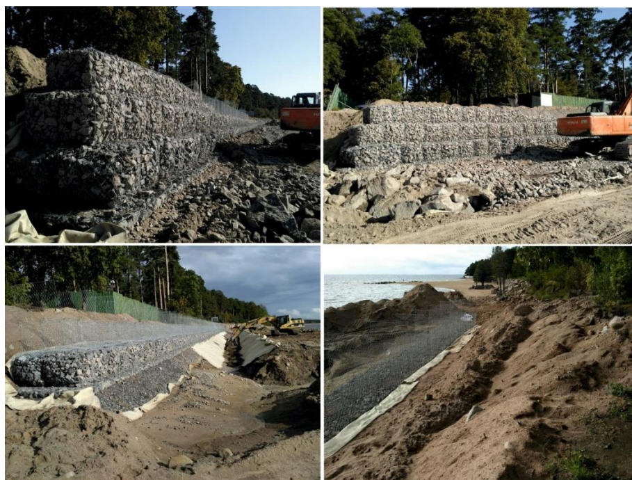
Рисунок 44. Строительство габионного укрепления на участке Правительственной резиденции
