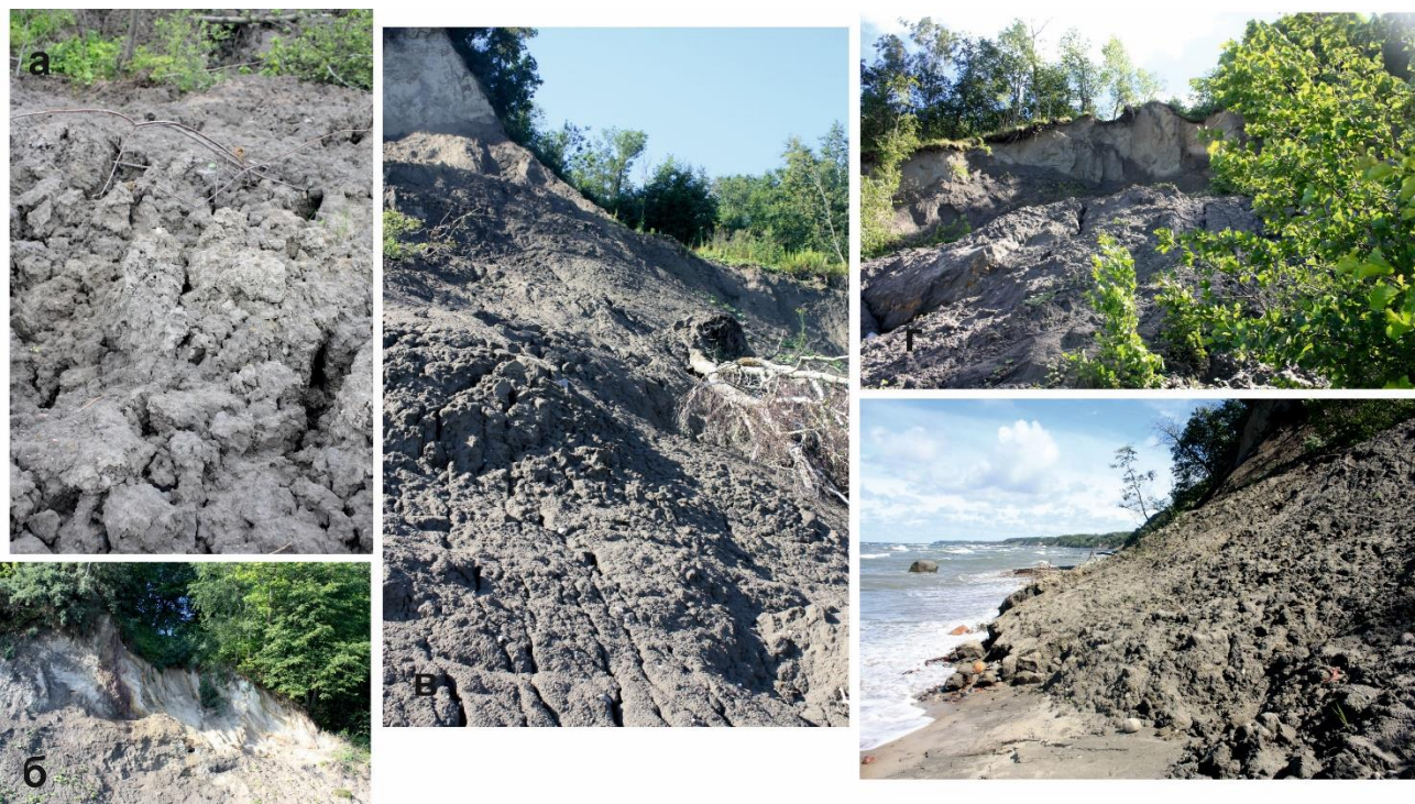
Рисунок 101. Оползневые шлейфы и осыпы. Станция наблюдения 17-ССБ-22: а, б – 2013 г. (станция наблюдения 13-ССБ-14); в – 2014 г. (станция наблюдения 14-ССБ-14); г, д – 2017 г. (станция наблюдения 17-ССБ-22)
