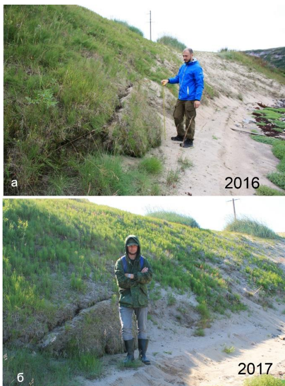
Рисунок 4. Оползневые процессы (2016 и 2017 гг.)
