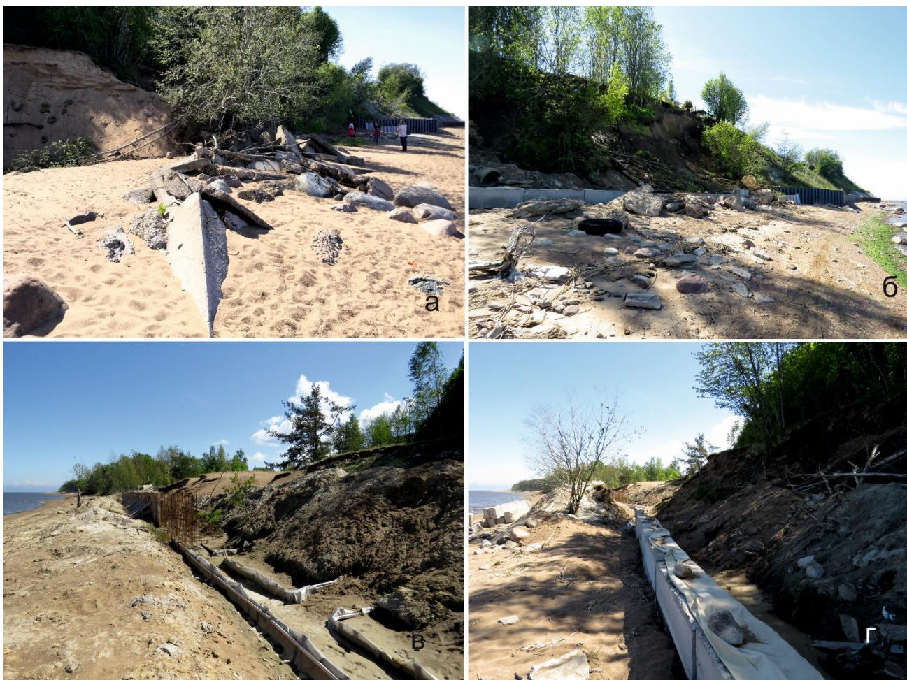
Рисунок 60. Осыпной абразионный уступ на западе пос. Лебяжье: а – незакрепленный участок берега на фоне берегозащитных сооружений в 2016 г. (фото 24 мая 2016 г.); б , в , г – начало возведения берегозащиты к востоку от укрепленного берега в 2017 г. (фото 6 июля 2017 г.)
