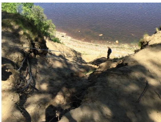
Рисунок 68. Необорудованный спуск к воде
