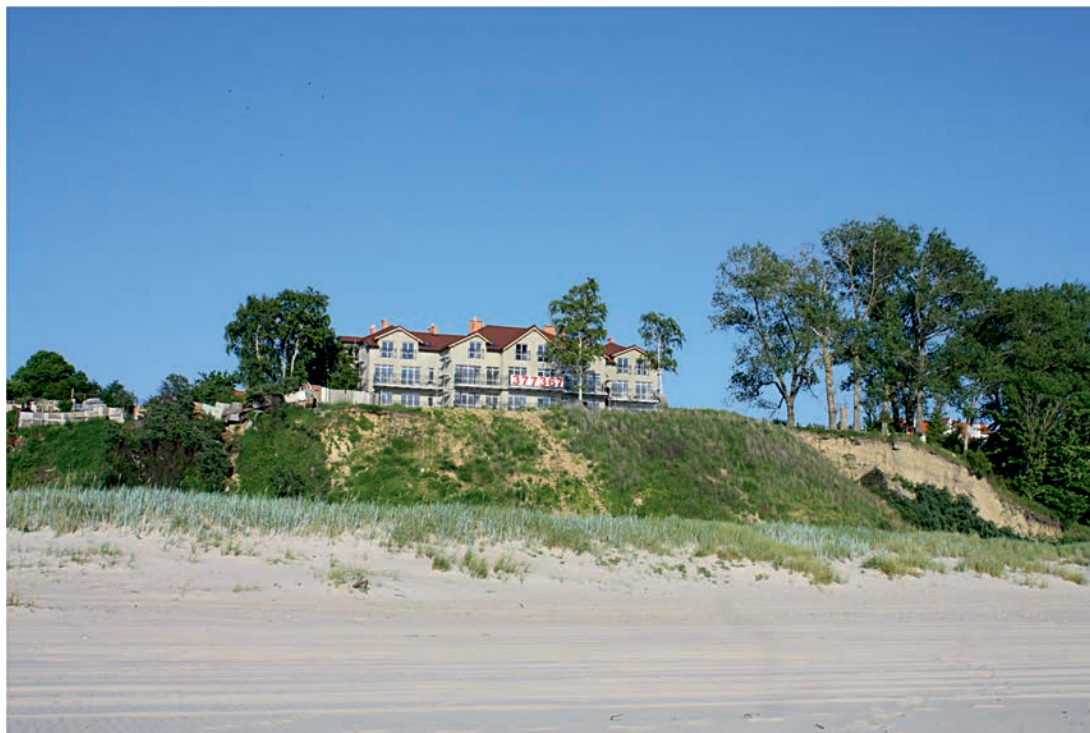
Рис. 137. Застройка бровки отмершего абразионного уступа, потенциально опасного из-за активизации обвально-оползневых процессов.
