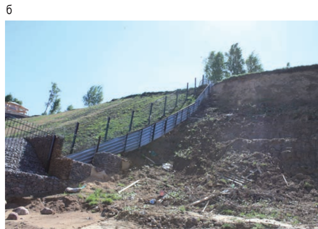
Рис. 57. Участок локального укрепления склона (а) и результаты его негативного воздействия на соседний участок (б).
