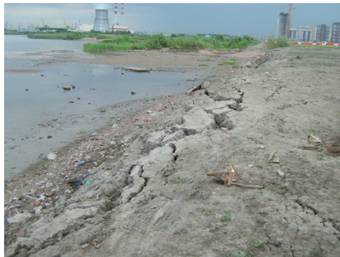
Рис. 93. а – Канонерский остров, размыв техногенной террасы при дефиците песчаных отложений на пляже, т.н. 13-НГБ-КАН-02. б – Устье реки Красненькой, просадка техногенной террасы.
