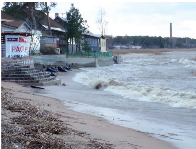
Рис. 59. Воздействие волнения на берегозащитные сооружения в пос. Лоцманское Селение. Фото 19.11.2013 г.
