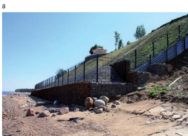
Рис. 57. Участок локального укрепления склона (а) и результаты его негативного воздействия на соседний участок (б).
