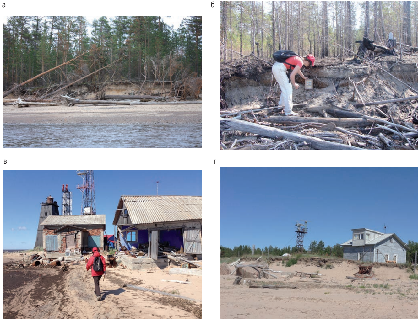
Рис. 26. Результаты активных абразионных процессов в северной части берега острова Мудьюгский: а – 2011 г., б – 2013 г., в-г – разрушение зданий в результате активных абразионных процессов в южной части острова (2013 г.).
