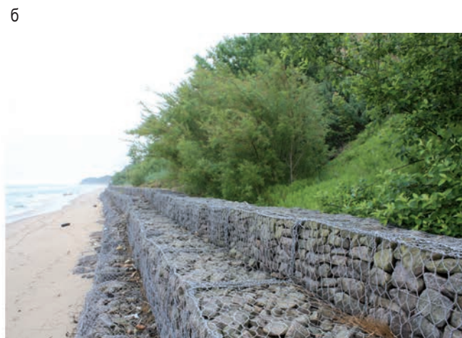
Рис. 122. а – участок берега перед Светлогорским променадом, б – стабилизация склонов, укрепленных габионами.
